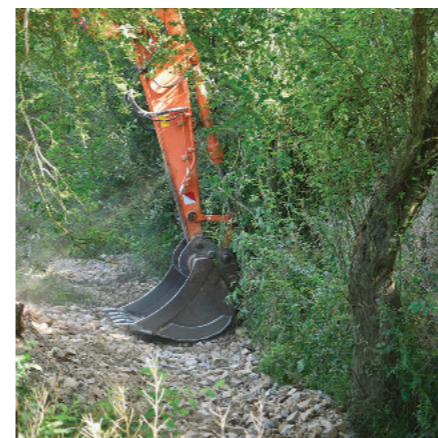
La pelle dépose puis tasse les pierres dans le lit (à sec cet été) pour combler les zones d'érosion.
