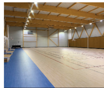
Les deux infrastructures désormais rénovées accueilleront les sportifs dans des conditions optimales, ici à Oudon.
