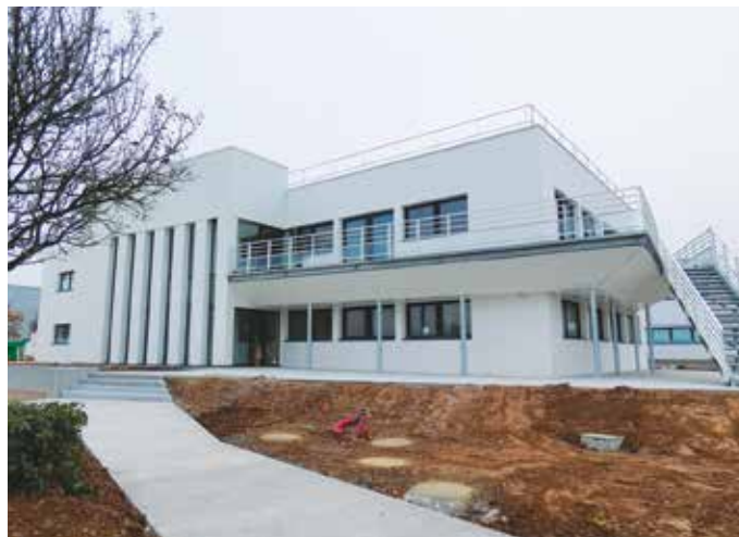
Le nouveau bâtiment de 725 m 2 permettra d'accueillir les porteurs de projet dans les meilleures conditions (photo prise en décembre 2022).
