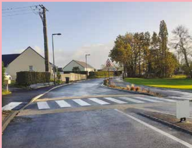
Les piétons peuvent désormais se déplacer en toute sécurité.
