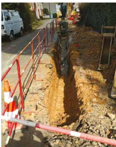
Pose du refoulement de Launay
