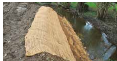
Janvier 2023, stabilisation de la berge : pose de branches de saule tressées ; apport de terre ; pose de géotextile ; plantations ; pentes douces.
