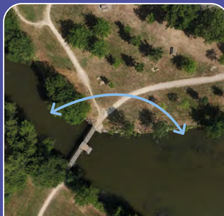
La future rivière de contournement à Vallons-de-l'Erdre.
