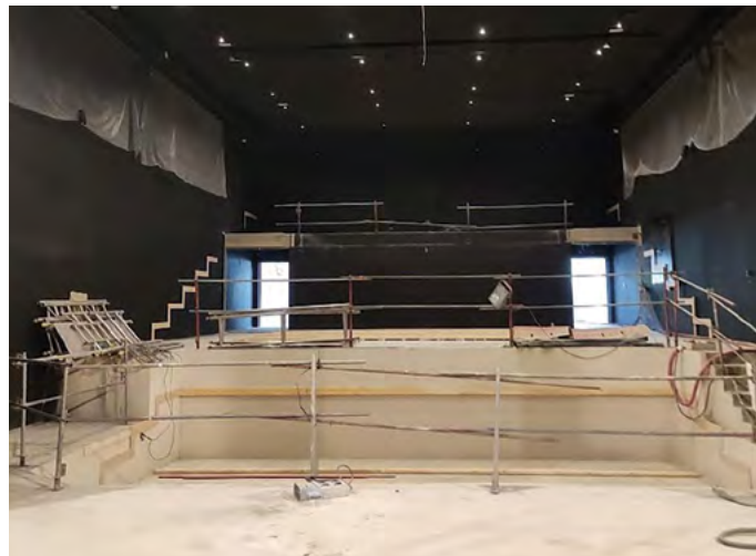
Ici, fin août, les travaux avancent dans la salle de spectacle.
