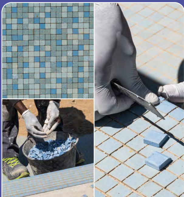
Chaque carreau est recollé à la main : un travail colossal !
